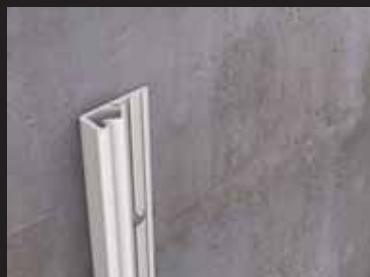
Pose du profilé de fixation
